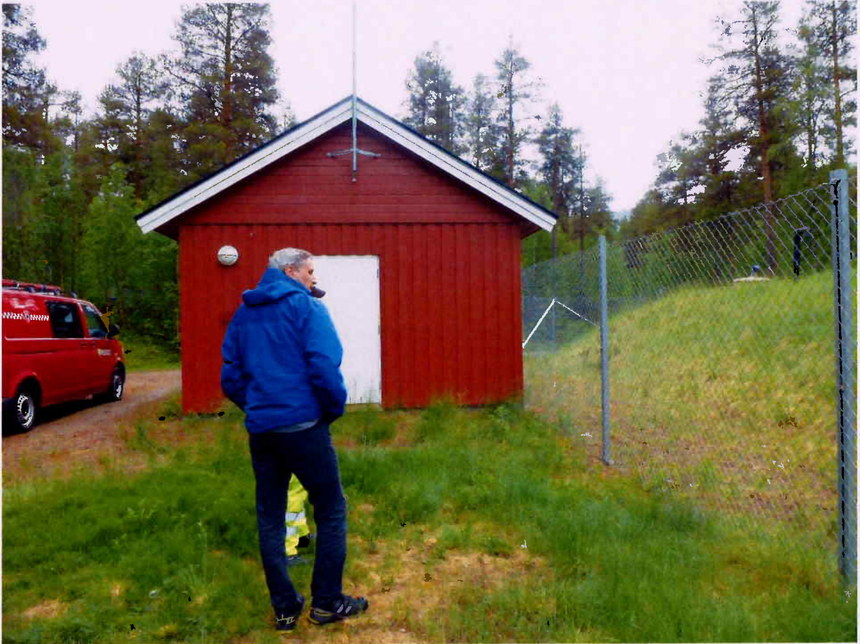
Bilde nr 5, viser vannbehandlingshus med delvis nedgravd utjevningsmagasin til høyre i bildet.
