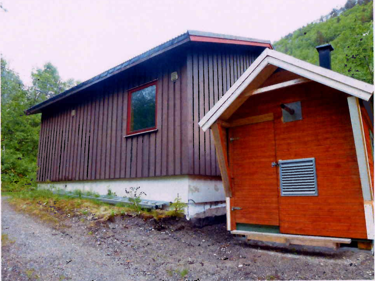
Bilde 2 viser vannbehandlingshuset til Ågleinåga vannverk. I forgrunnen ser vi tilbygget med nødstrømaggregat.
