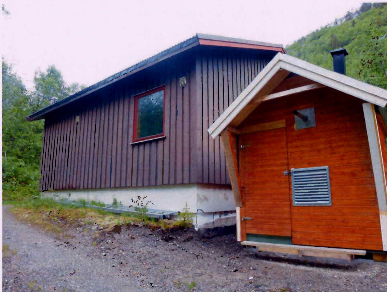
Bilde 2 viser vannbehandlingshuset til Ågleinåga vannverk. I forgrunnen ser vi tilbygget med nødstrømaggregat.
