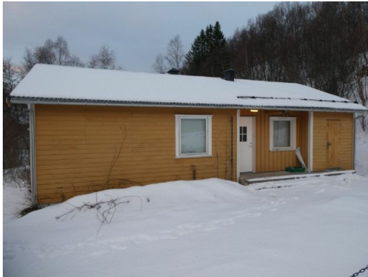
Yttertak dekket med snø
