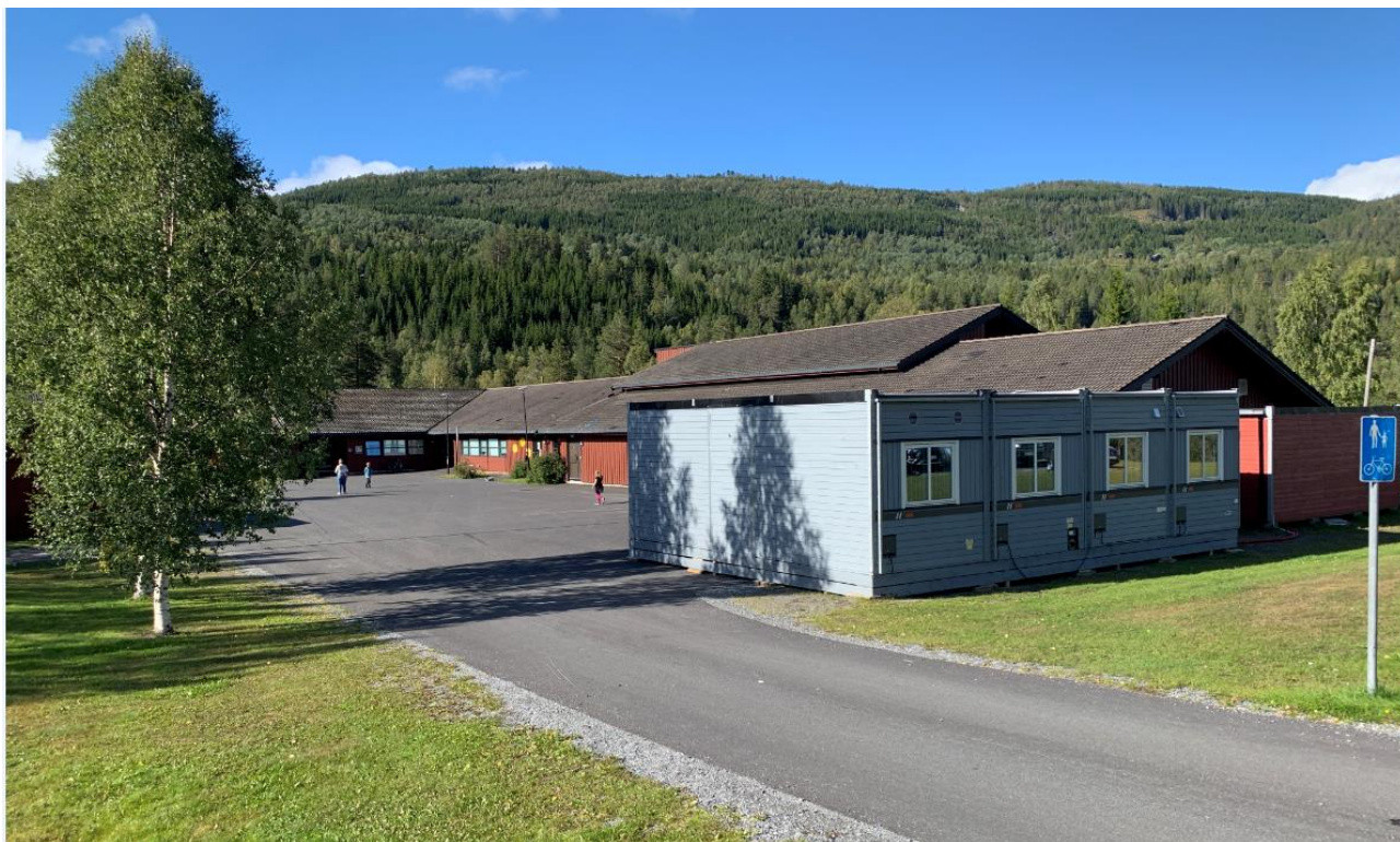
Figur 5. Trones skole / Beiarn barne- og ungdomsskole. Midlertidige tilbygg i forgrunnen. Foto M Selnes 2020.09.09.
