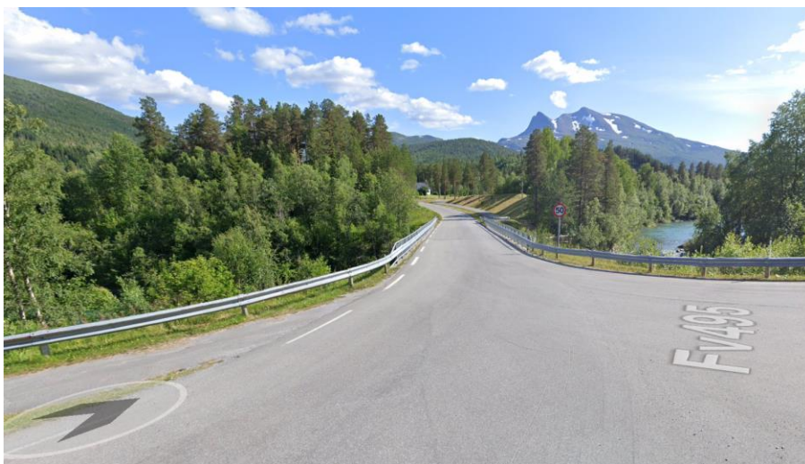
Figur 32. Bru over Beiarelva ved Trones (google streetview).
