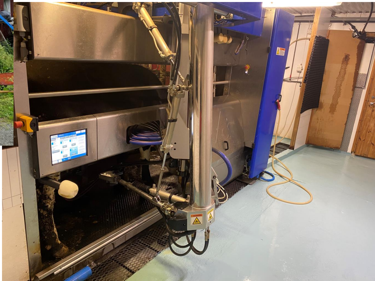
Roboten instalert og i drift
