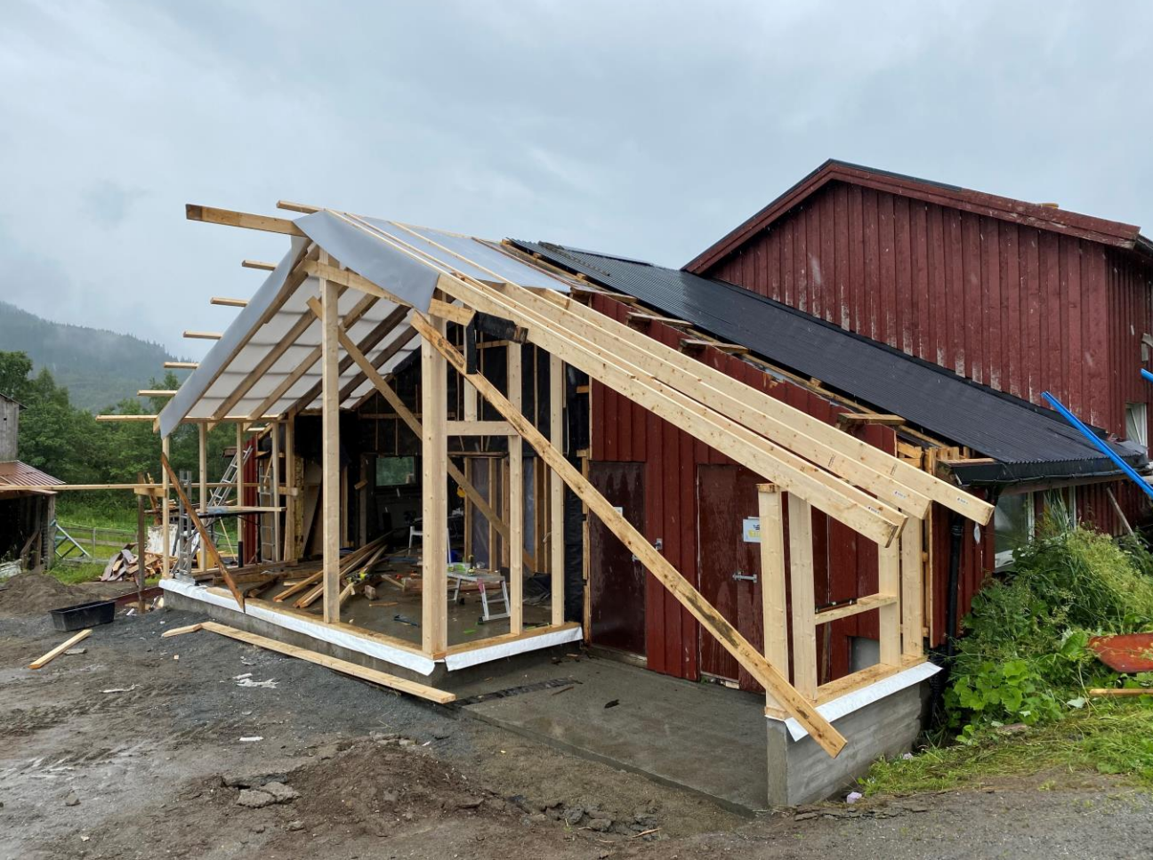
Bygging for robot
