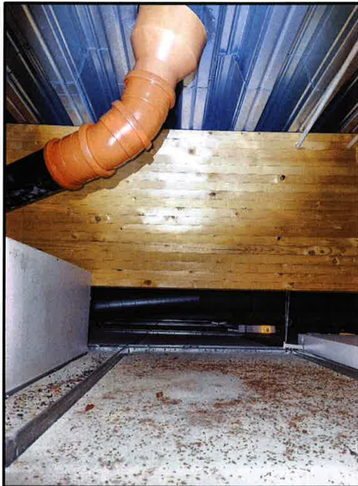
Figur 3.1-14 – Tak over 2. etg., utbygd del. Limtre drager.
