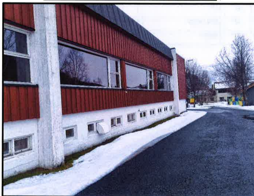
Figur 3.1-1 - Generell tilstand hovedfløy, fasade nord. Hhv. øst og vest.
