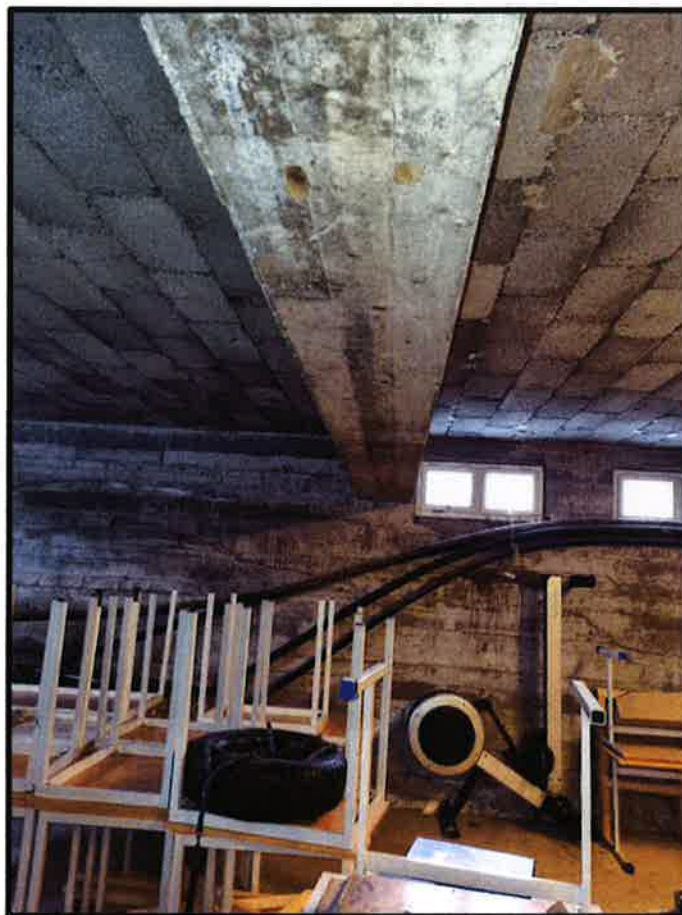
Figur 3.1-3 - Tilstand innvendig, kjellertg. Uinnredet. Bilde fra vestre del av etasje.
