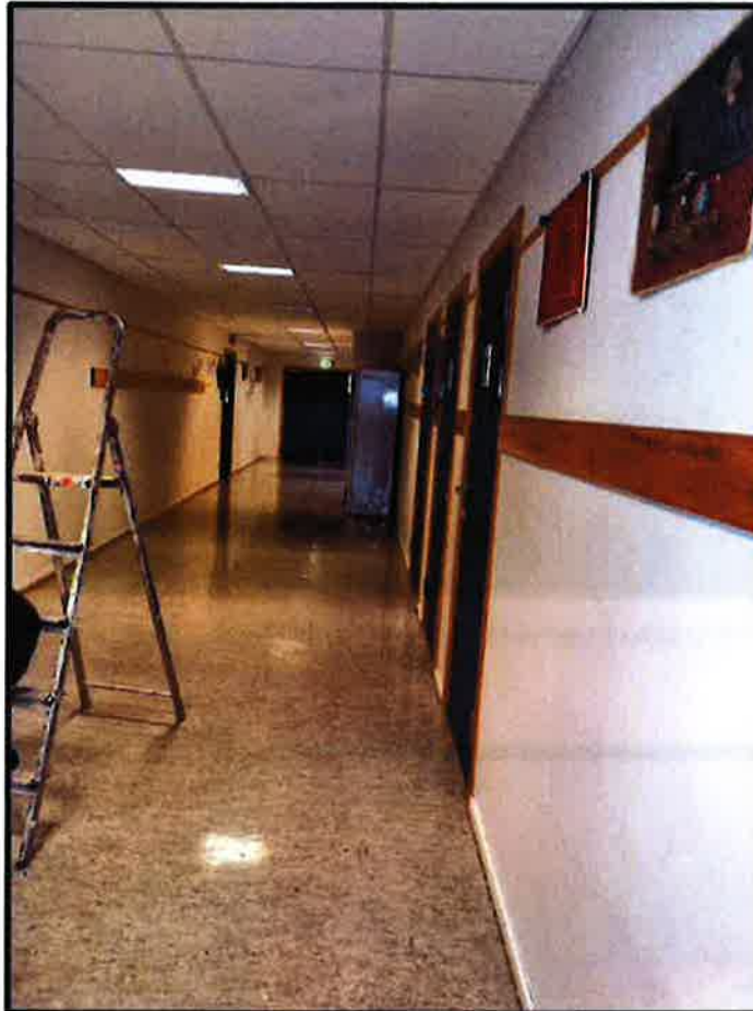
Figur 3.1-12 – Gulvbelegg og himling, korridor 2. etg
