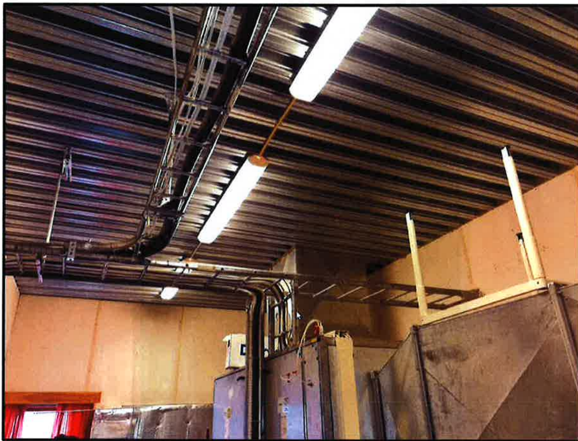
Figur 3.1-9 – Yttervegg 2. etg, nordre del og yttertak.
