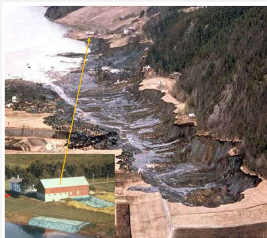
Figur 2.2 Rissaskredet 1978. Skredets utbredelse kommer frem av det store bildet. Innfelt bilde viser utgraving og oppfyllingen som forårsaket initialscredet, illustrert av Kjell Karlsrud, NGI. Foto: Adresseavisen
