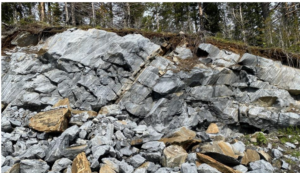
Figur 13: Bergskjæring langs eksisterende veg med tilbakefylte masser i fot av skjæring.
