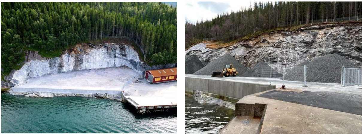
Figur 4-3: Tilgrensende areal for havnelagring ble utvidet i 2021. Bildet til høyre viser at arealet benyttes til lagring av grus. Bilder fra Beiarn kommune.
