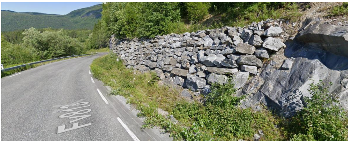
Figur 2-11: Bergskjæring og tørrsteinsmur, ca. P720.
